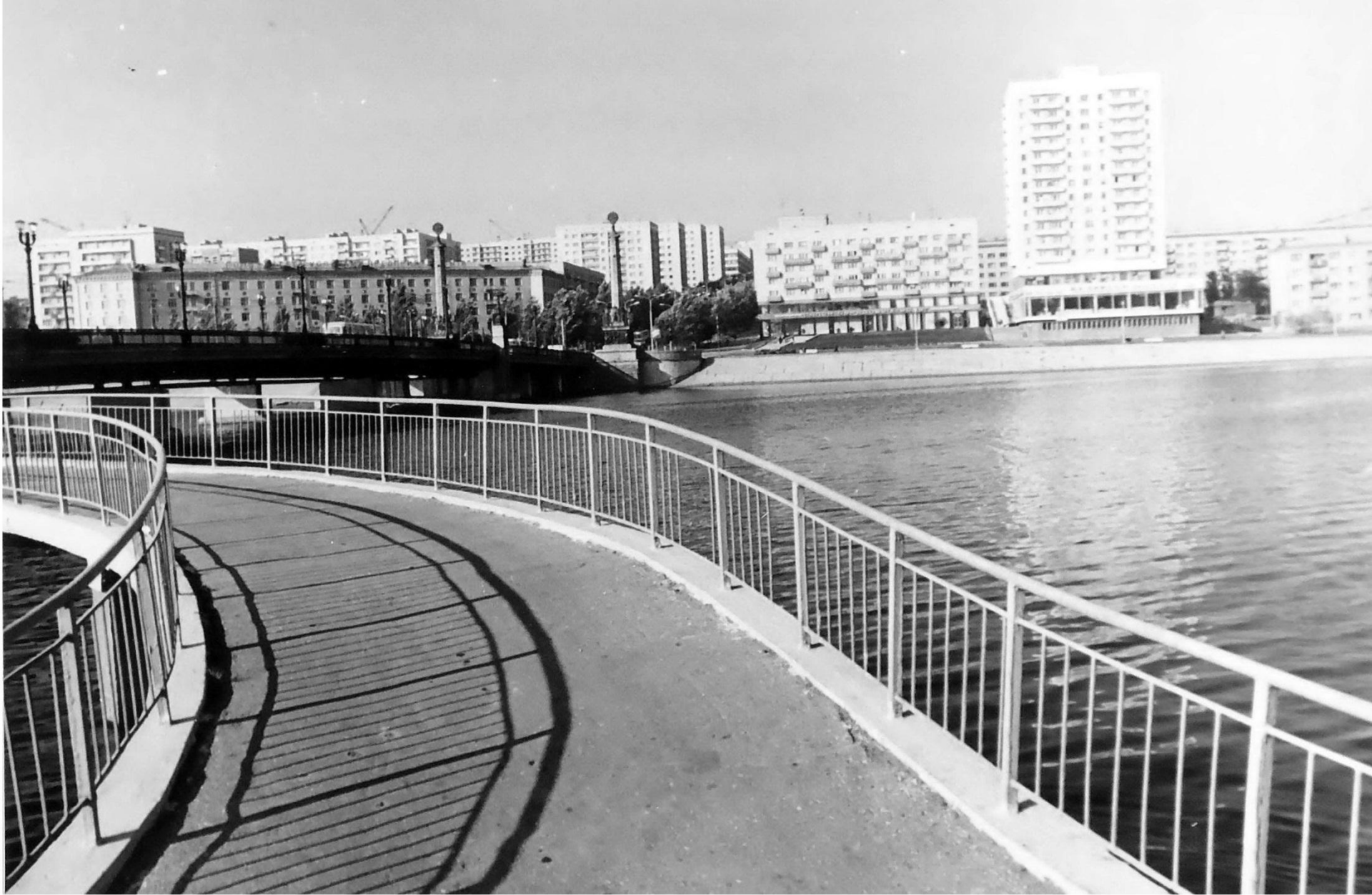
Мост через р. Кальмиус в г. Донецке
