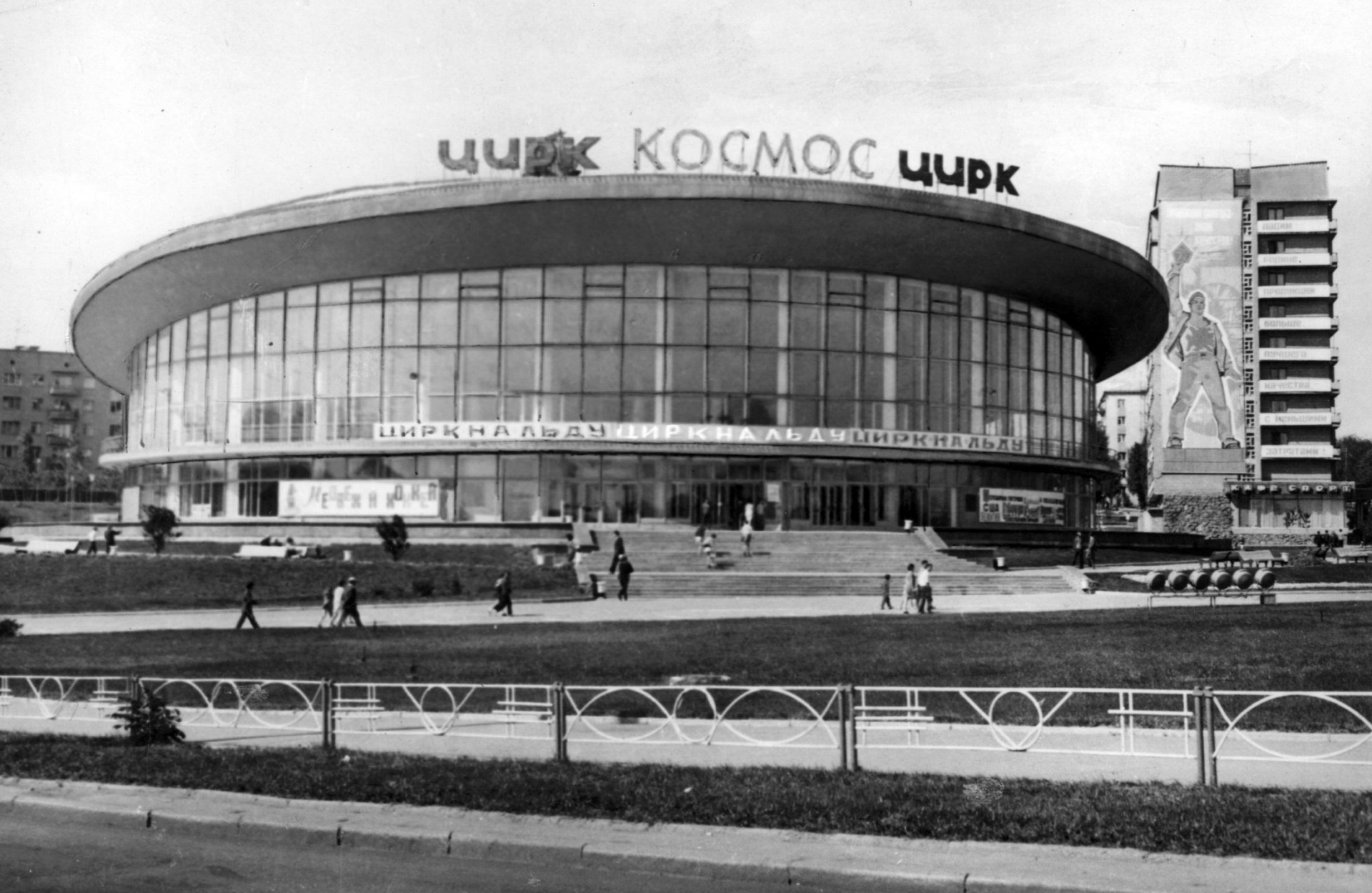
Общий вид здания цирка «Космос» в г. Донецке 1970 г.
