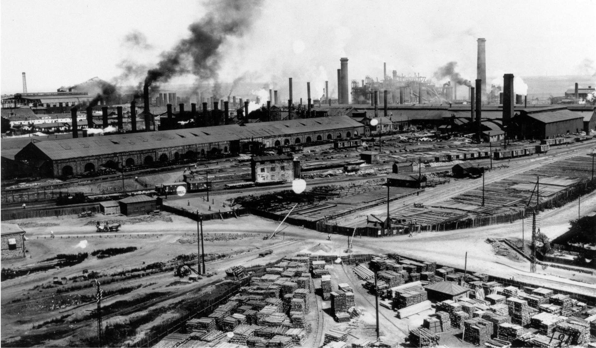
Завод Новороссийской компании в г. Юзовка со стороны шахты Заводская 1912 г. Государственный архив ДНР, фонд фотографий, С17, фото № 30
