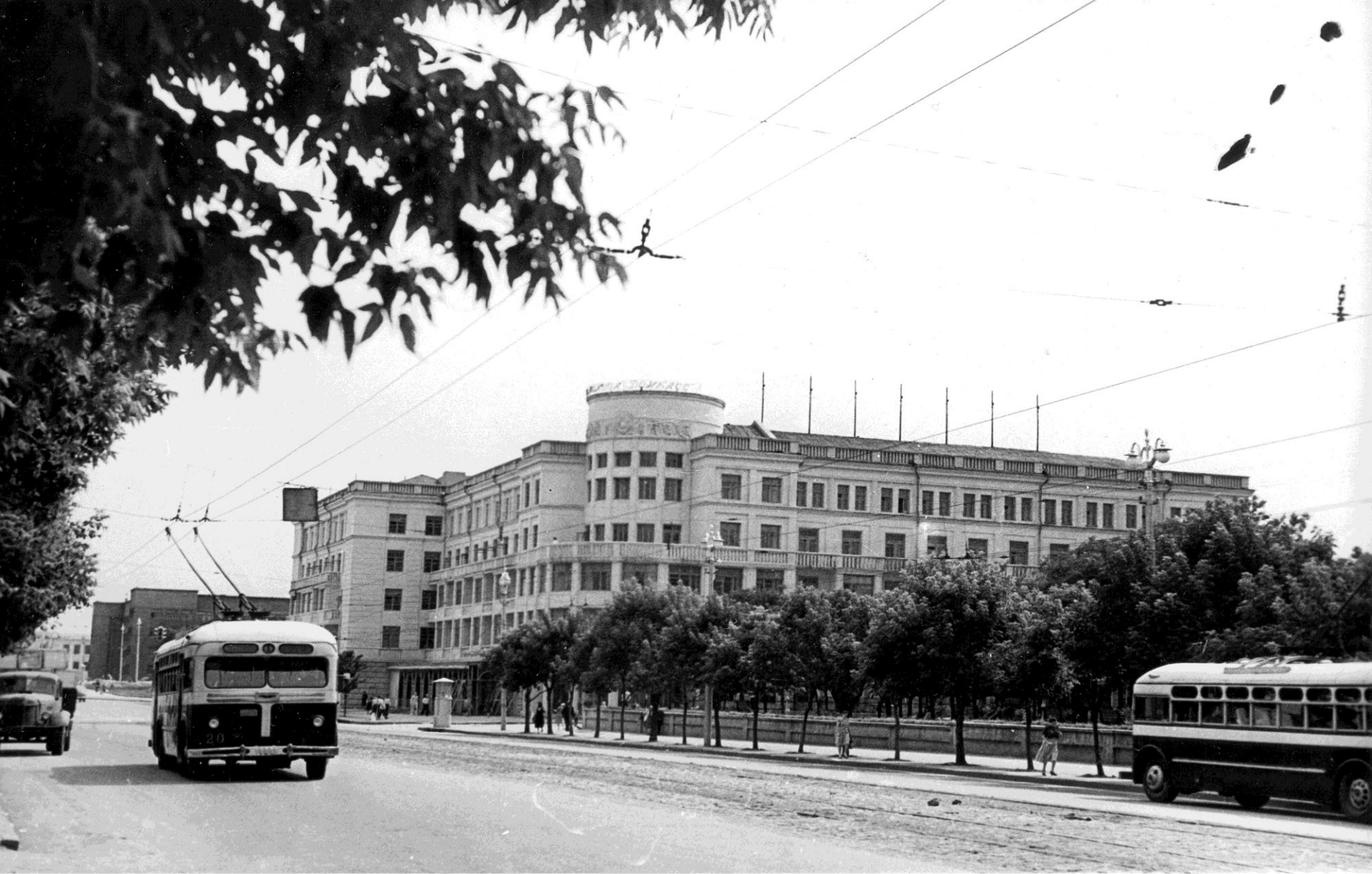
Внешний вид здания гостиницы «Донбасс» в г. Сталино 1951 г.
