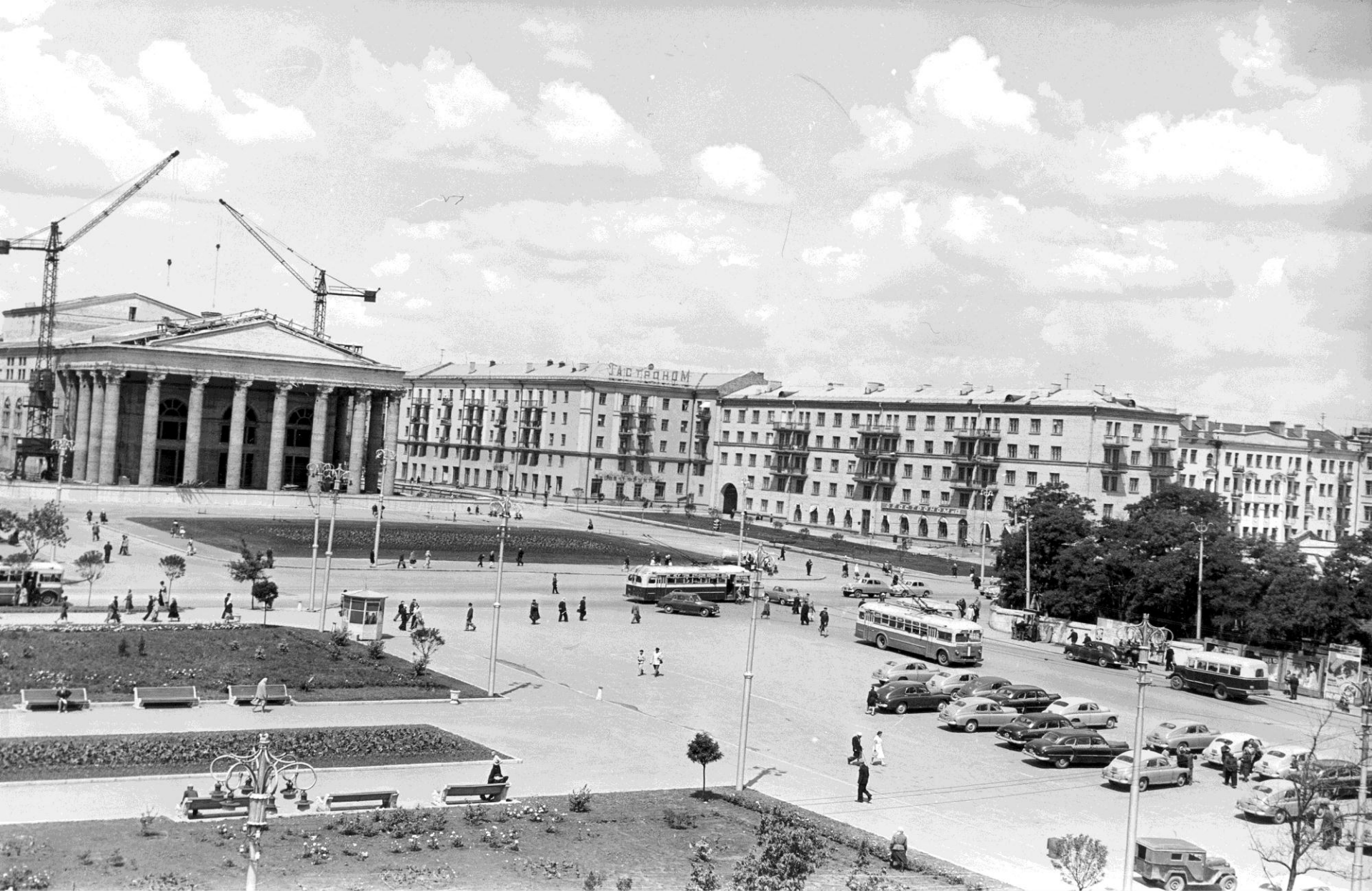
Площадь Ленина в г. Сталино. Слева - строительство здания драматического театра, справа – новые жилые дома для рабочих и служащих завода 1958 г. Государственный архив ДНР, фонд фотографий С19_195
